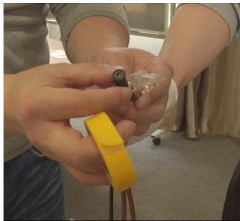
3. 把2根网线和1根电源延长线的头部用胶带扎在一起（注：电源延长线一定是母头）
